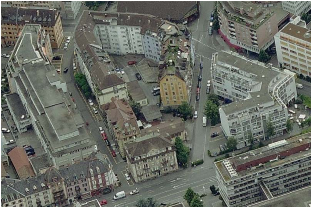
Luftaufnahme; heutige Baulücke an der Brünigstrasse 5, unvollständiger Blockrand
